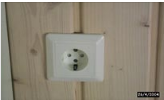
Kuva 2. Suojamaadoitettu pistorasia
