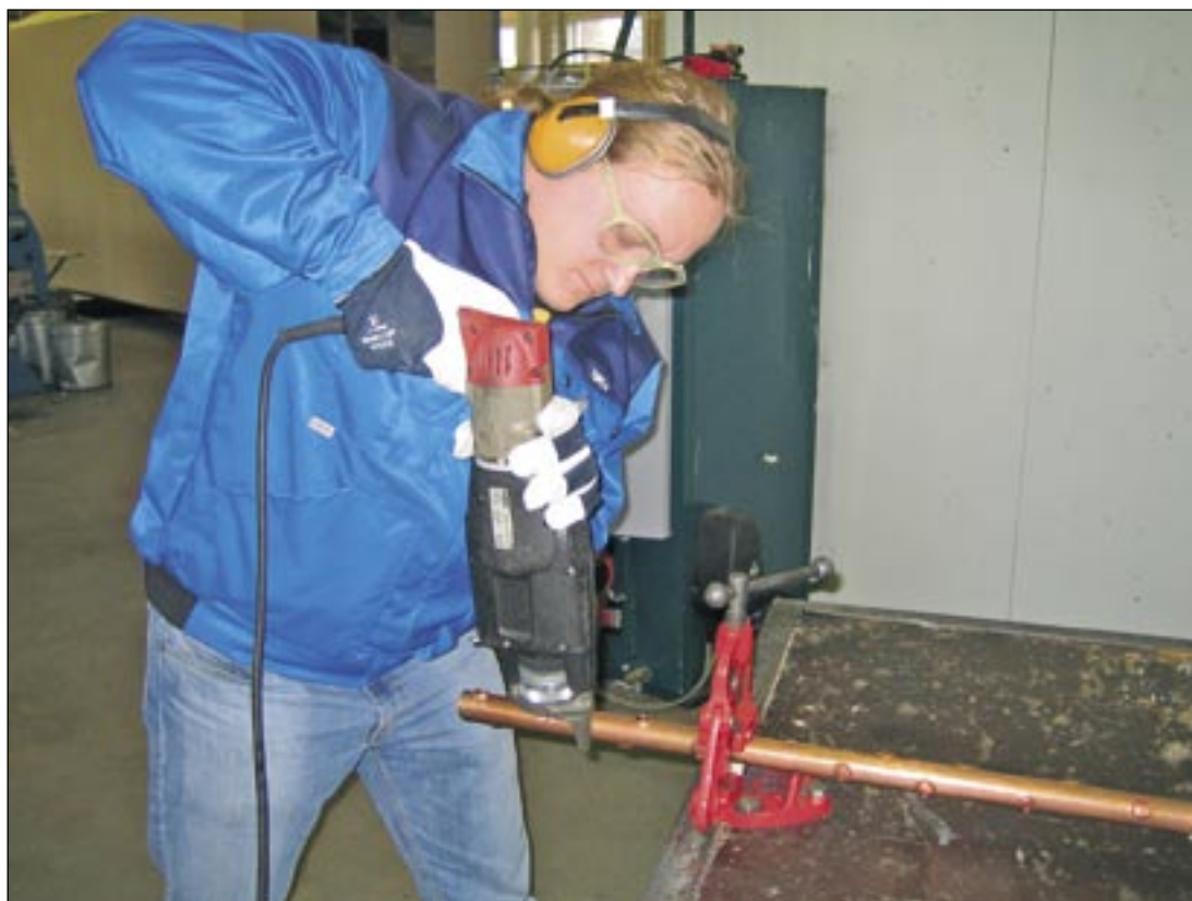
Kuva 19. Haaroitustyökoneella työskentely
