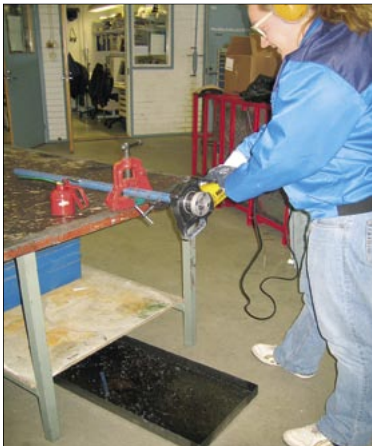
Kuva 14. Sähkökäyttöisellä käsikierrekoneella työskentely
